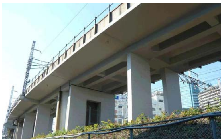
図 2-6 壁式ラーメン高架橋の例 4)
