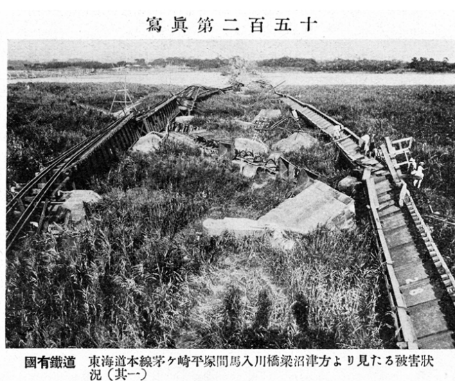
図 2-14 馬入川橋りょうの被害 30)
