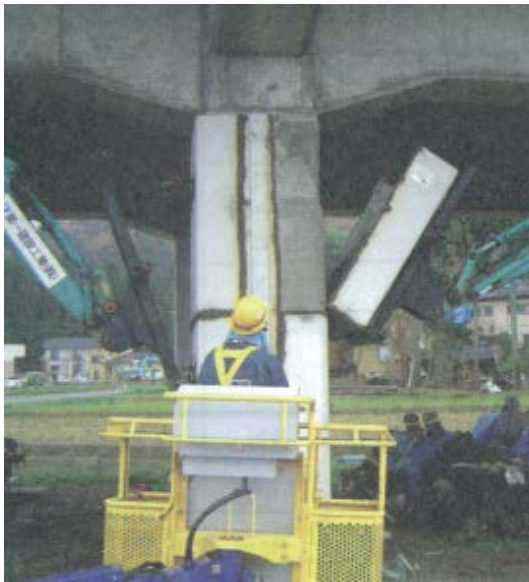
a) 鋼板の撤去状況
