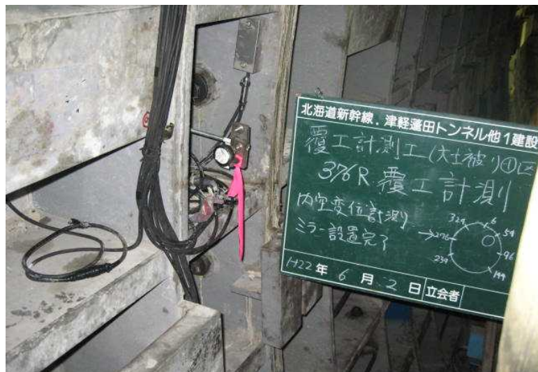
写真 2-1 内型枠に設置した内空変位計測用ターゲット設置状況
