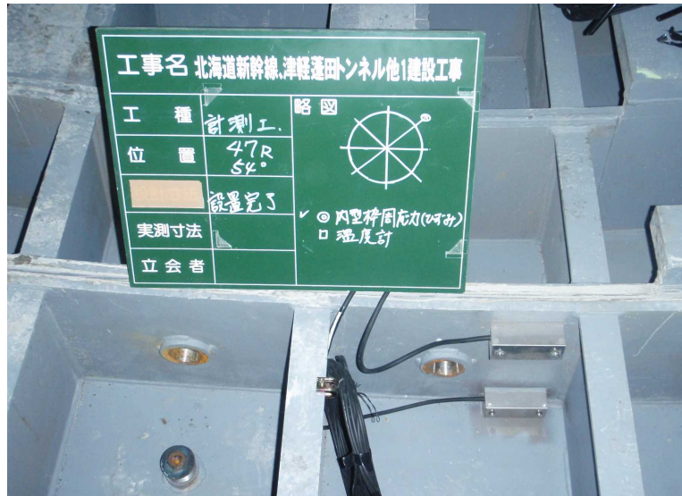
写真 2-2 ひずみ計設置状況
