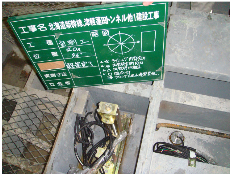
写真 2-4 ひずみ計押し込み装置設置状況
