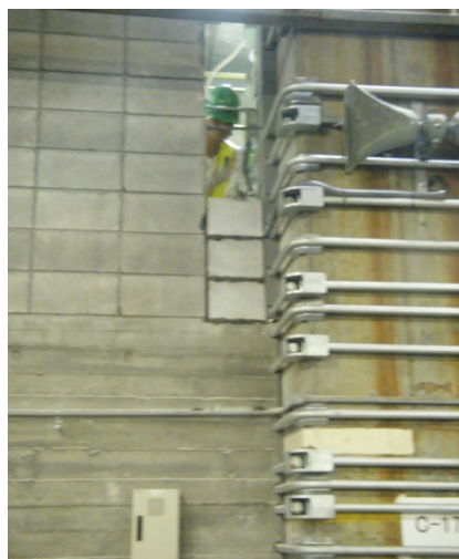
[壁を復旧しながらの鋼材配置の状況]
