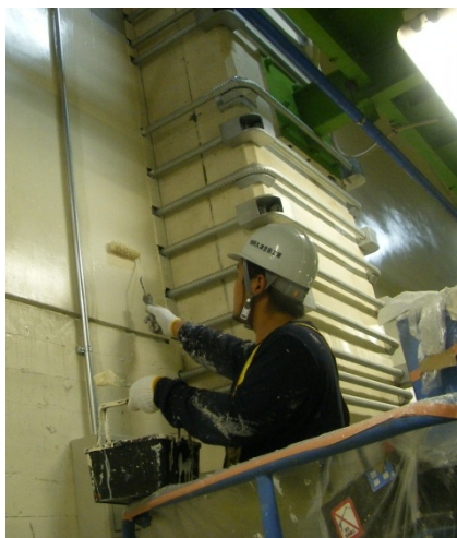
[上部の仕上げ状況]
