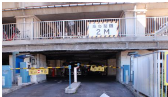
写真 5.1.1 柱の中間に付置義務駐輪場の床が設置されている既設 RC 柱の例
