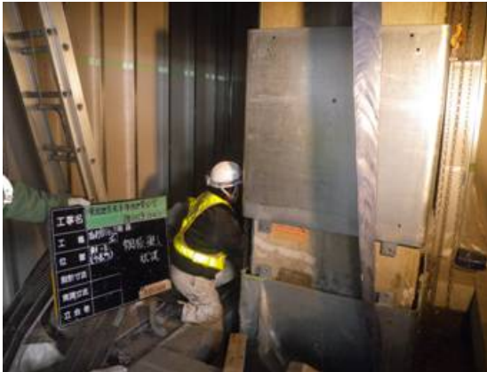
写真 4.3.6 鋼板の設置状況（コンコース平面 交差箇所）
