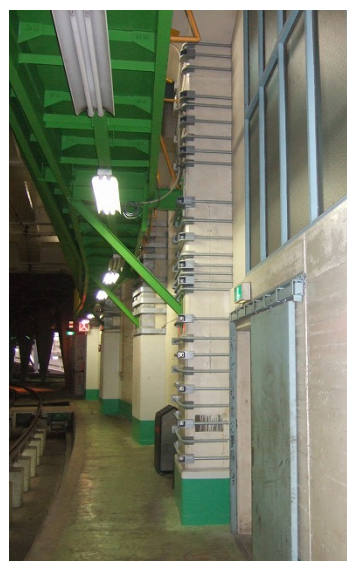
写真 4.4.4 壁の復旧, ナット緩み止め
