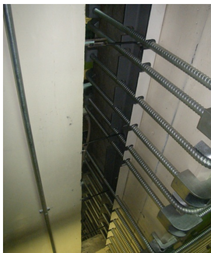
[上部ブロック復旧前の溝形鋼設置状況]
