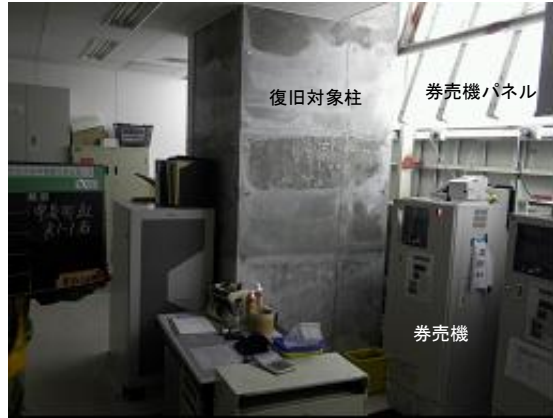
写真 4.3.7 券売機室内の柱周辺状況
