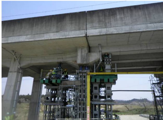
写真 4.3.1 ジャッキアップ状況
