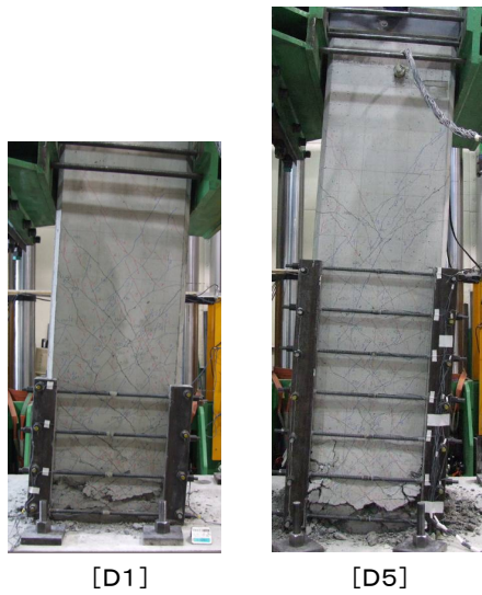
写真 5.4.3 载荷後の損傷状況 (D 1, D 5)
