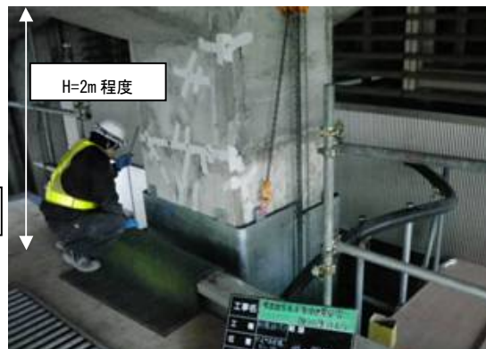
写真 4.3.5 店舗上空の作業スペースの状況
