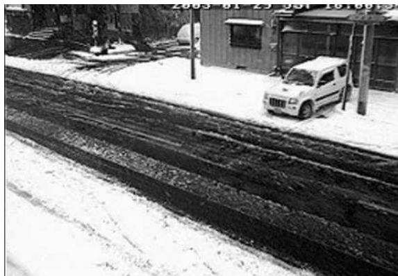
図1 節水型消雪パイプの融雪状況（2003年1月29日）
