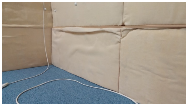
図 2 グラスウールで作成した吸音ボード
