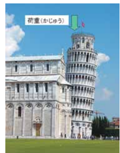
Foto 1. Hundimiento de la Torre de Pisa
