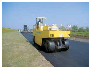
Figura 3 Compactación de la mezcla de asfalto.
