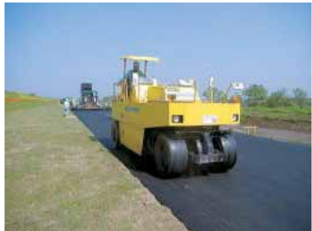
図3 アスファルト混合物の締固め
