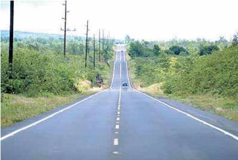
図1 アスファルト舗装
