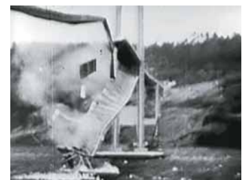
Foto 1. Colapso del puente Tacoma Narrows
