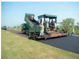
Figura 2 Extensión de la mezcla de asfalto.
