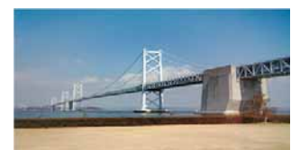
Foto 6. Gran puente de Seto (1,723 m de longitud, construido en 1988)
