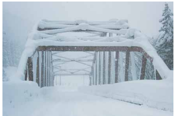
写真3 雪の積もったアーチ橋
