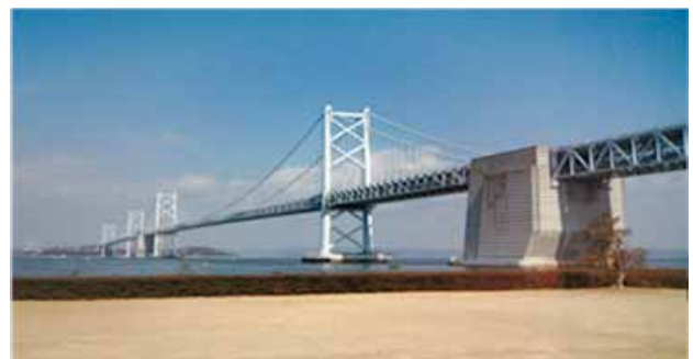
写真6 瀬戸大橋（1988年から、橋長1723m）
