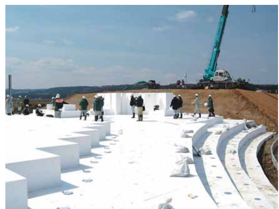
写真3 EPS工法 (長岡国道事務所提供)
