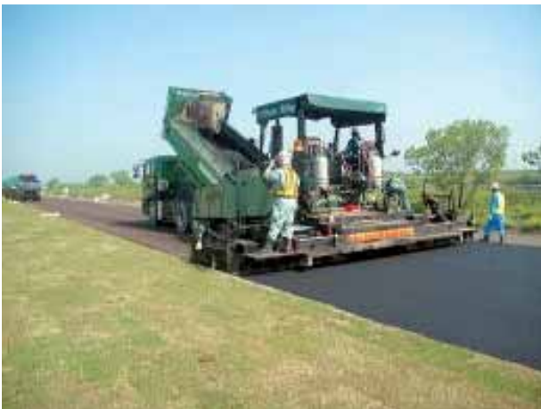
図2 アスファルト混合物の敷均し
