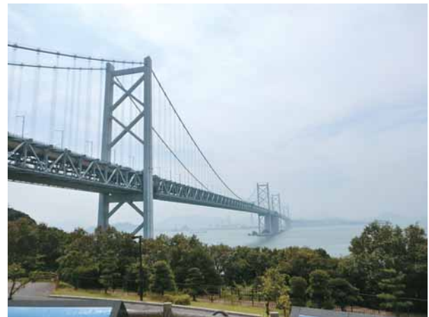
写真5 瀬戸内海の島に架かる吊橋
