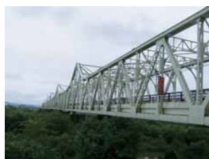
Foto 2. Puente de armadura en la ciudad de Nagaoka
