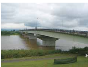
Foto 1. Puente de viga en la ciudad de Nagaoka
