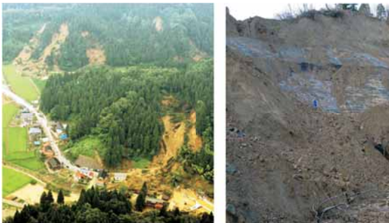
a) Falla de pendiente causada por la lluvia (ciudad de Nagaoka, proporcionada por la Oficina de Desarrollo Regional de Hokuriku, Ministerio de Tierra, Infraestructura, Transporte y Turismo)
