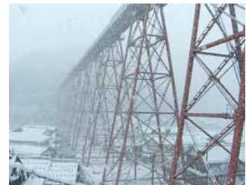
Foto 1. Puenete de viga de Amarube (construido en 1912)
