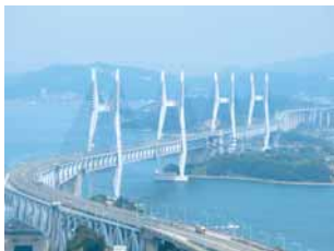
Foto 4. Puente atirantado que conecta una isla en el mar interior de Seto
