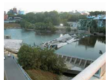
Foto 4. Puente en Minnesota, EE. UU.
