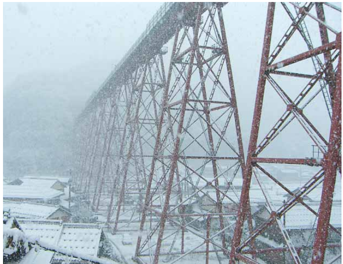
写真1 餘部橋梁（1912年建設）
