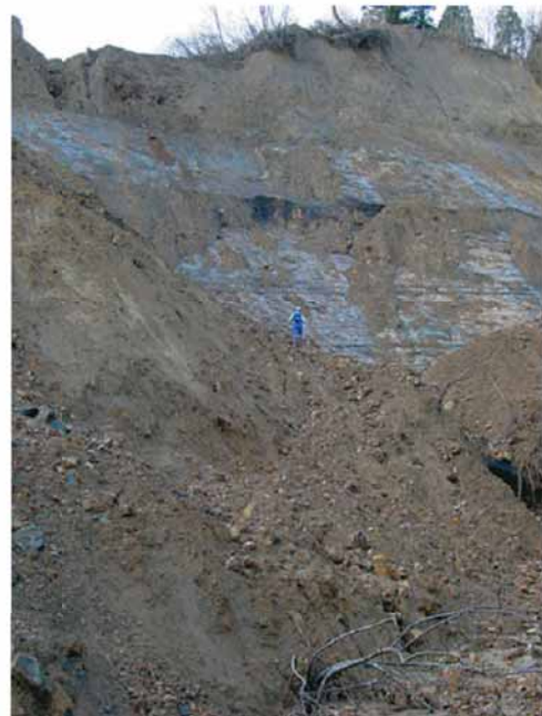
(b) 地震による斜面崩壊（小千谷市）
