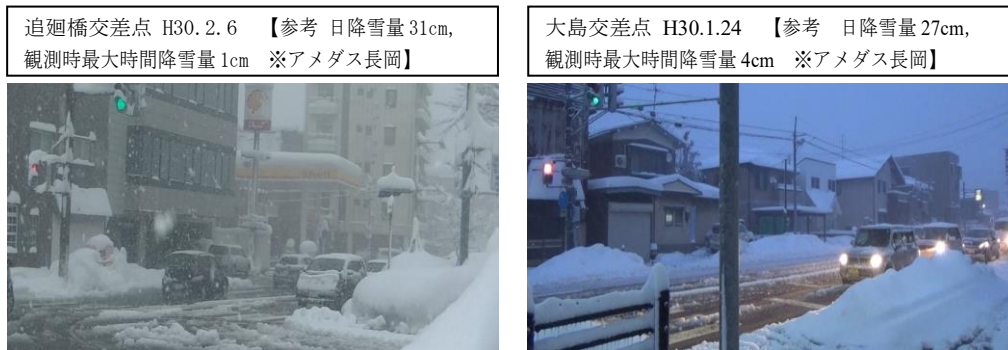
図 3-4 消雪パイプ設置区間における観測時の路面状態
