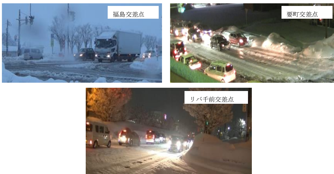
図 3-2 観測時の主な路面状態 (上左：シャーベット, 上右：圧雪(凸凹), 下：圧雪(滑))
