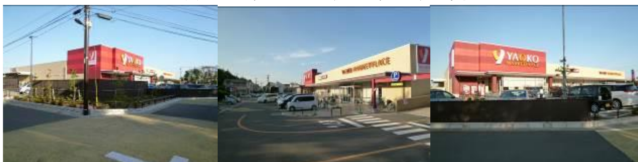
写真 4-4-3 商業ゾーン（商業施設）の状況
