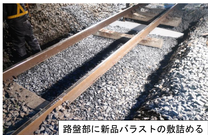
(b) 新品バラストの敷き詰め
