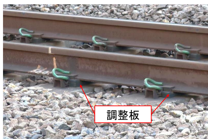
図 1.1.3 既設線省力化軌道におけるレールレベルの整正
