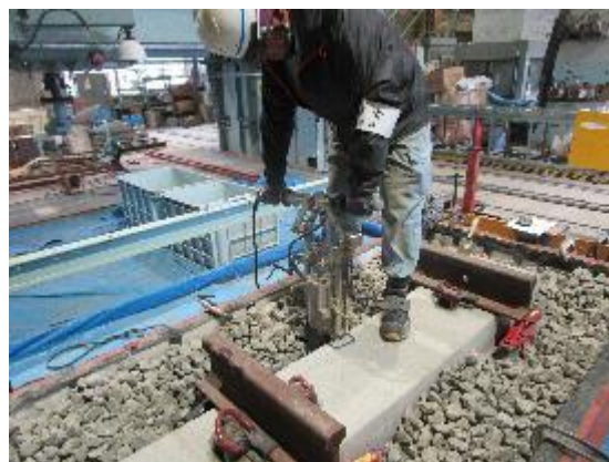
(d) 予備載荷後の軌道整備
