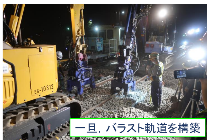
(d) 一旦、バラスト軌道を構築する
