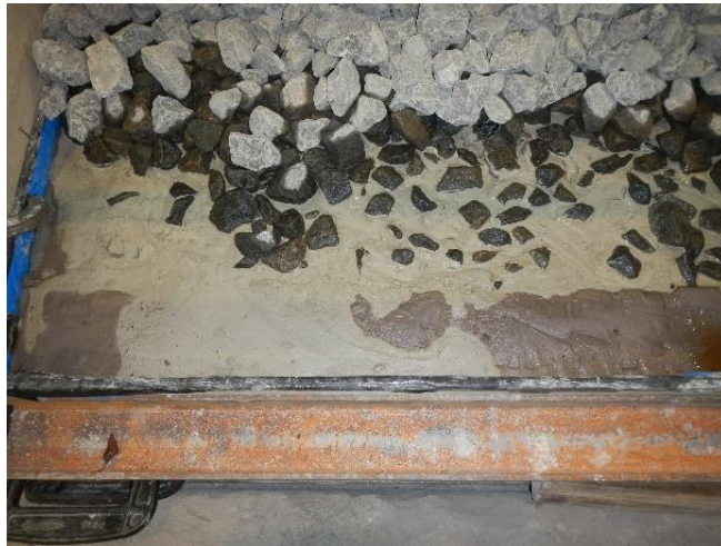
(k) グラウト充填後の路盤改良層表面の状況
