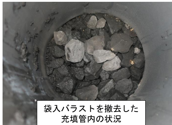
(a) 充填管内の状況
