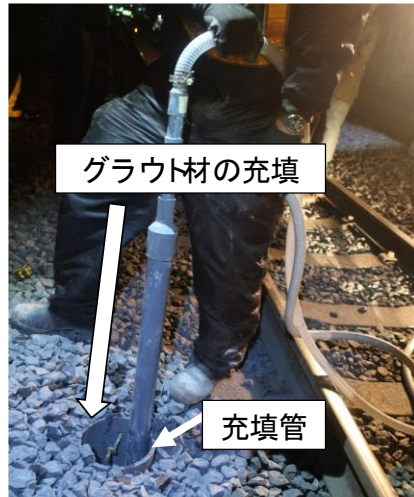
(c) グラウト材の充填作業の状況②
