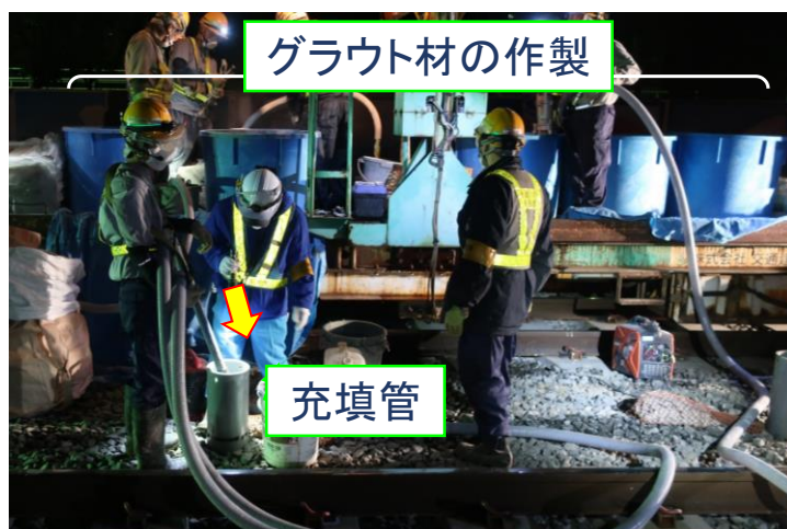
(d) グラウト材の充填作業①
