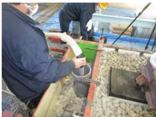
(e) 路盤部へのグラウト材の充填
