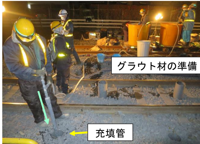
(b) グラウト材の充填作業の状況①
