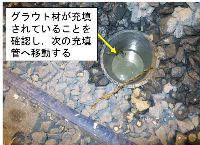
(e) 充填後の充填管内の状況 図 2.5.6 グラウト充填作業
