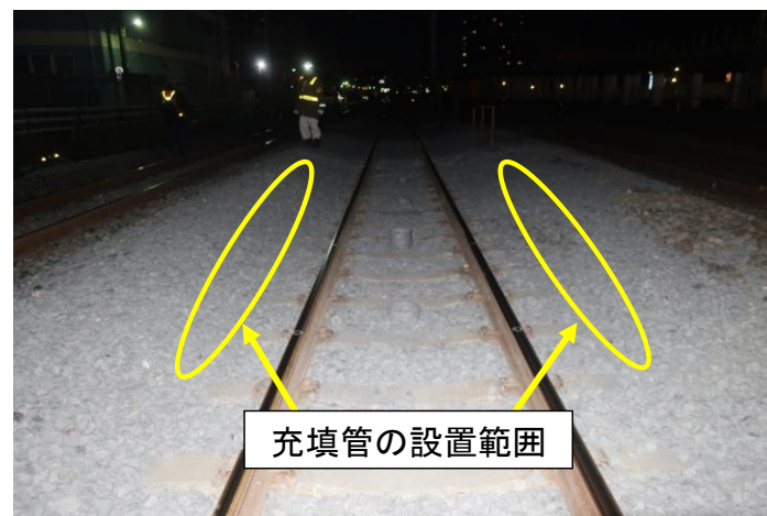
(d) 復旧したバラスト軌道 図 2.5.5 路盤置換え作業
