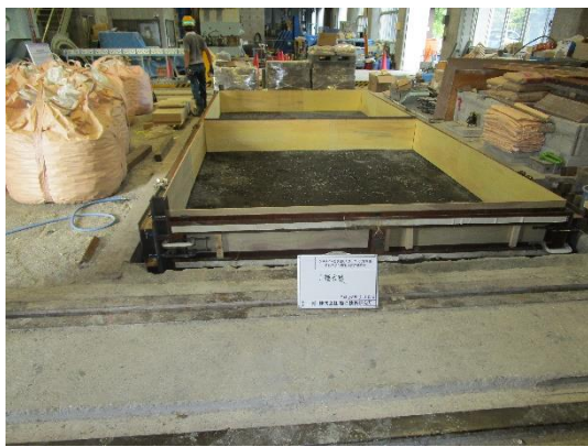
(a)粘性土路盤の構築枠の設置
