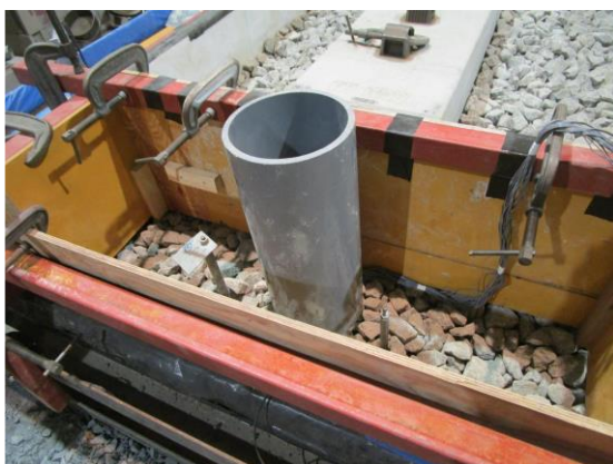
(c) グラウト材の充填管の設置
