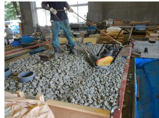
(h) 新品バラスト道床の構築
