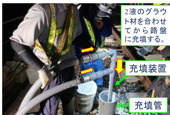
(e) グラウト材の充填作業②
