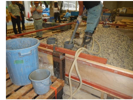
(j) グラウト充填の状況
