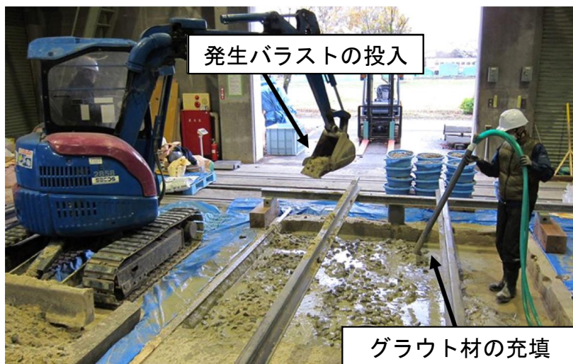
図1.4.3 グラウト充填路盤改良工法（発生バラスト方式）のグラウト充填状況
