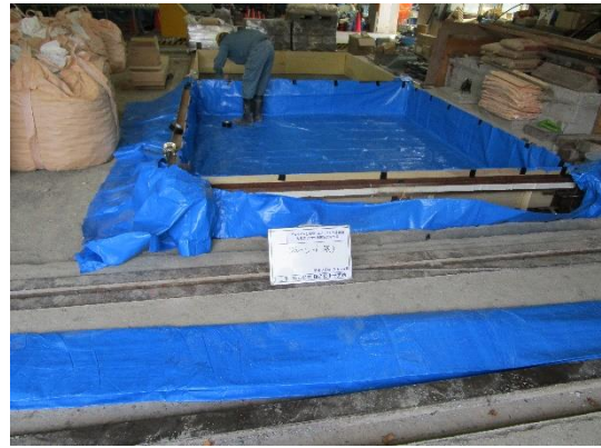
(b)遮水シート敷設
