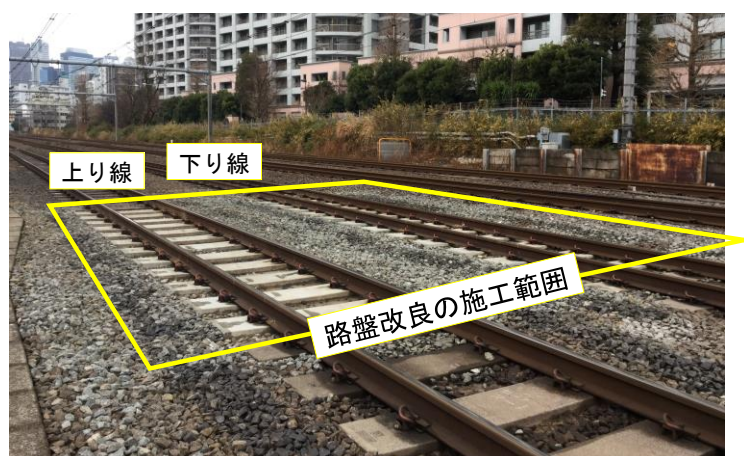
(f) 施工後の状況
