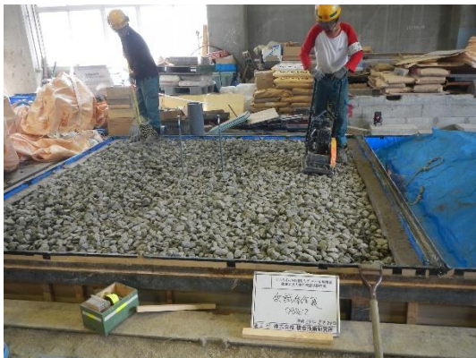
(g) 路盤改良部（新品バラスト）の締固め状況
