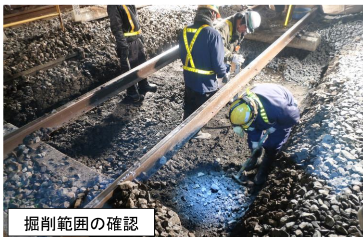
(a) まくらぎ、道床および路床の掘削
