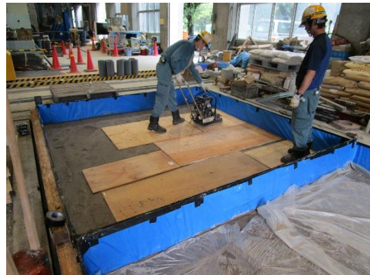
(d)粘性土層の転圧
