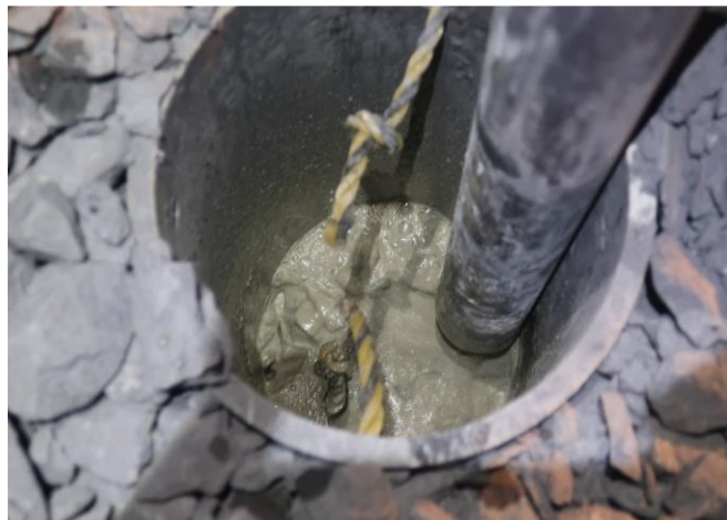
(d) グラウト材の充填作業の状況③
