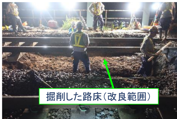
(a) 既設線省力化軌道の撤去および路床土の掘削
