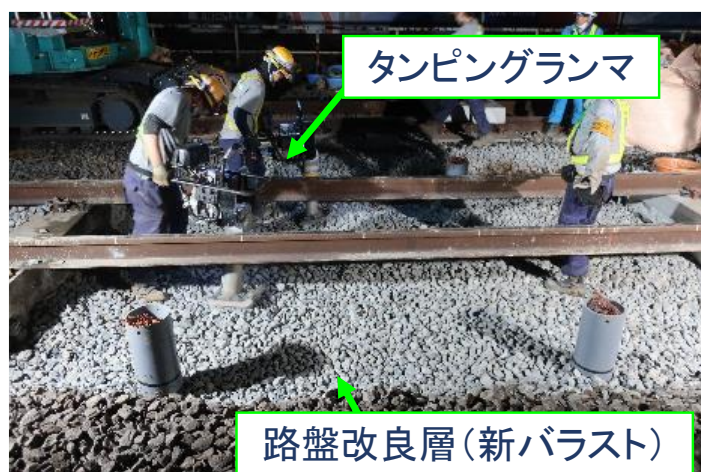
(b) タンピングランマによる敷詰めた新バラストの締固め状況
