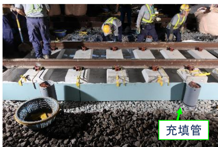
(c) 新バラスト上に省力化軌道を構築する型枠の設置
